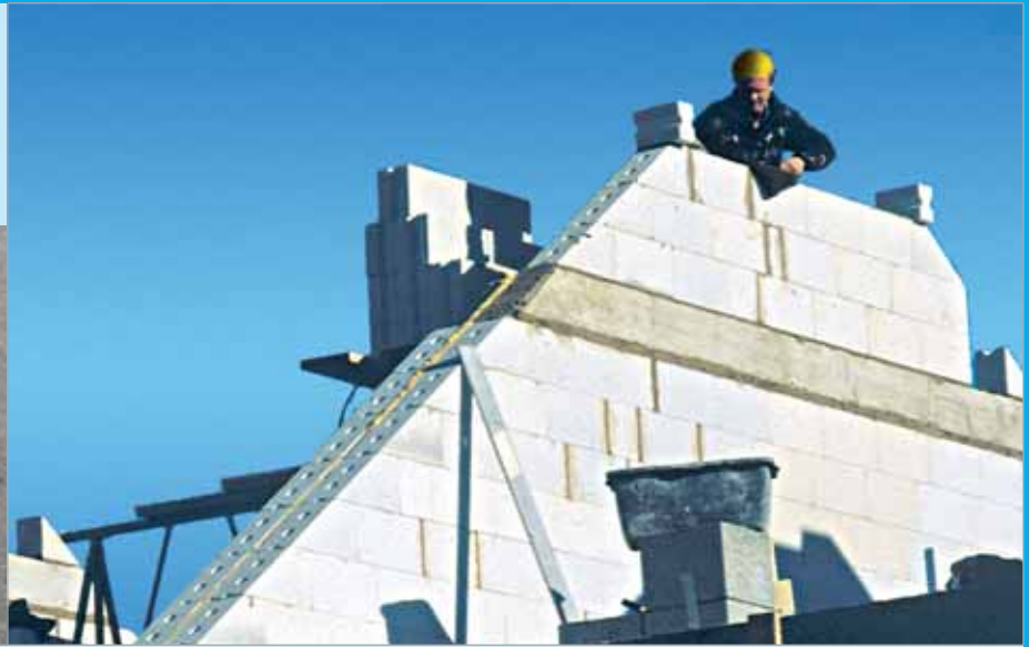
▲ Für eine exakte Giebelschräge werden E-Stein-Giebelsteine verarbeitet.
